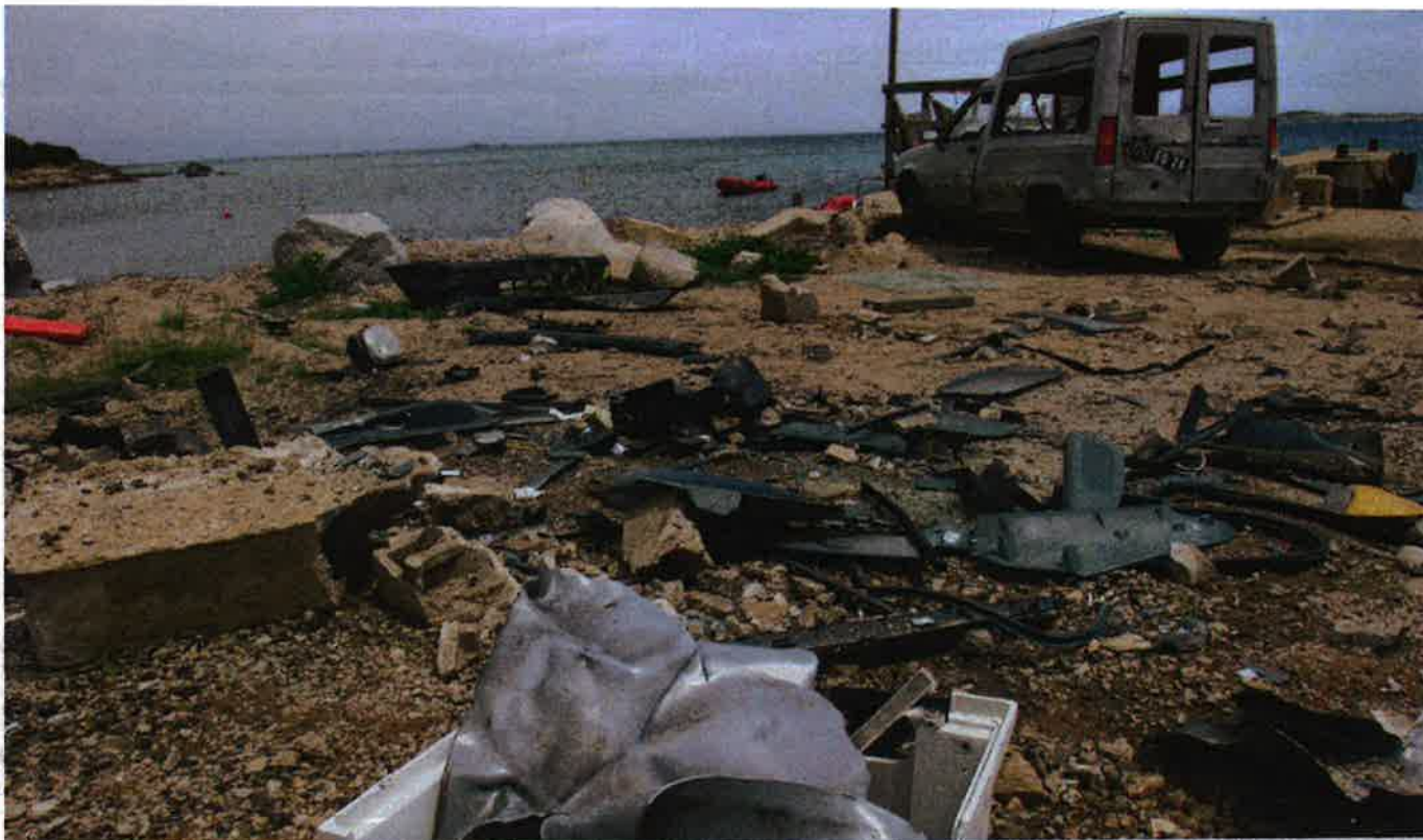
▲ En 1999, une bombe détruisait entièrement le système d'alimentation en eau de l'île de Cavallo.
